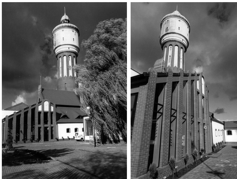
Rys. 7. Elewacja frontowa SUW
