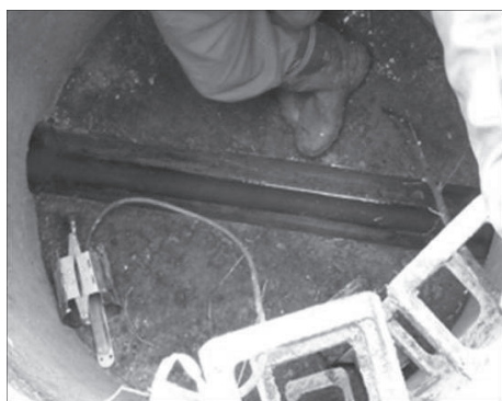
przeptywomierz ultradźwiękowy (PCM F firmy NIVUS)
