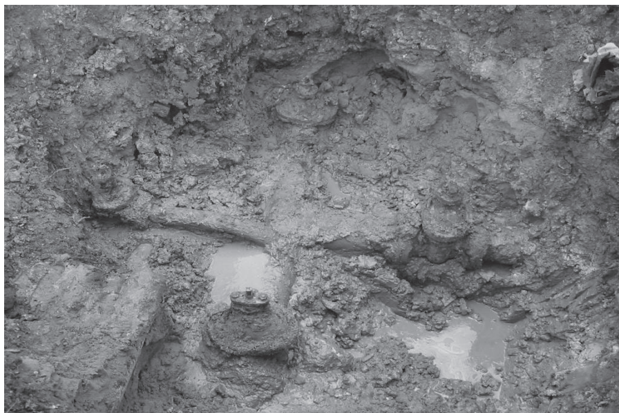
Rys 6. Odkopany, nie zinwentaryzowany węzeł zasaw oraz przyłącze
