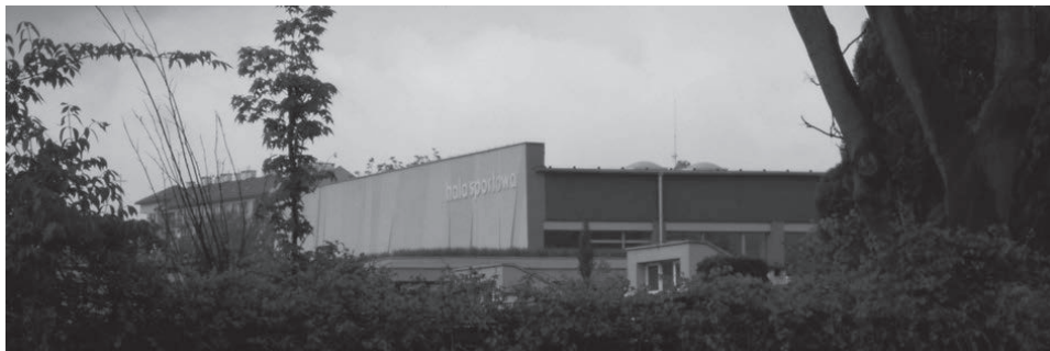
Rys. 8 Fragment dachu hali sportowej Uniwersytetu Rolniczego w Krakowie pokryty trawą Pic 8. Part of the roof of the sports hall of the University of Agriculture in Krakow covered with grass
