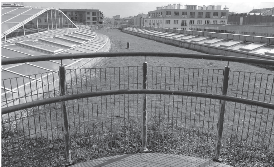
Rys. 4 Ogród zielony na dachu Biblioteki Uniwersytetu Warszawskiego Pic 4. Green garden on the roof of University of Warsaw Library
