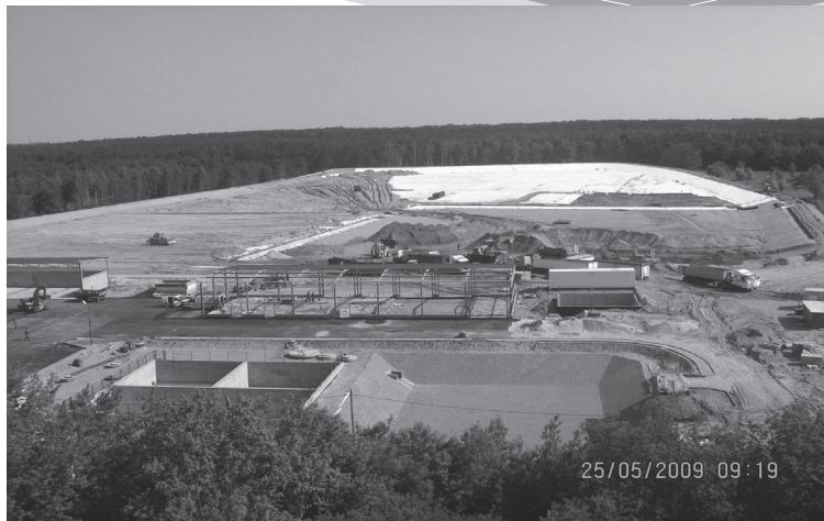
Budowa ZUOK m. Toruń
