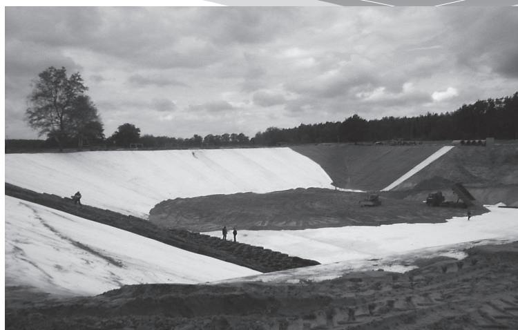
Budowa niecki składowiska odpadów komunalnych m. Szprotawa
