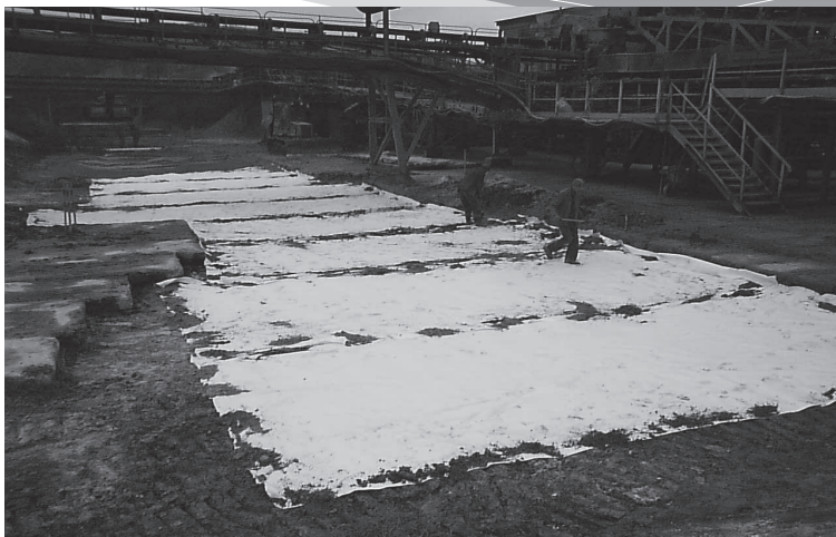
Budowa drogi dojazdowej na składowisku fosfogipsu w ZCH Police
