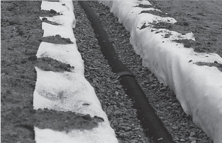
Odwodnienie nasypu pod pas jezdny autostrada A4
