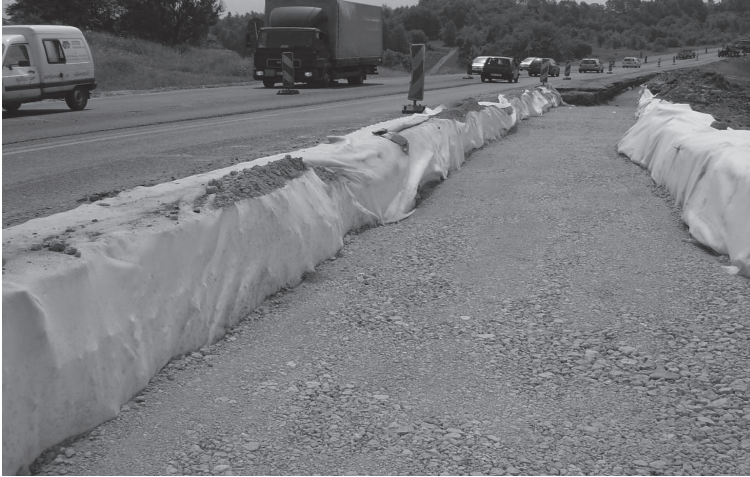
Poszerzenie nawierzchni DK4 odcinek Kraków 33 Tarnów
