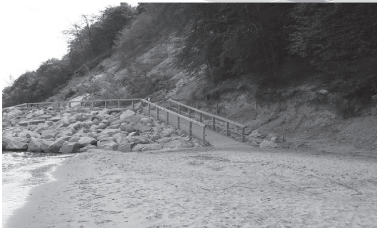
Zabezpieczenie osuwiska brzegu morskiego „Babie Doły” m. Gdynia
