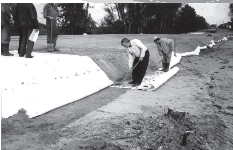
Odbudowa nasypu drogi DW 338 po powodzi, odcinek Lubiąż - Kawice
