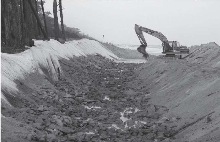
Umocnienie brzegu morskiego m. Dźwirzyno
