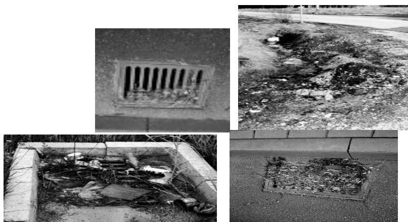
Rys. 3. Przykład niedrożności wpustów ulicznych
