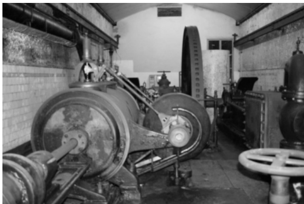
Fot.1 Pompa parowa.
