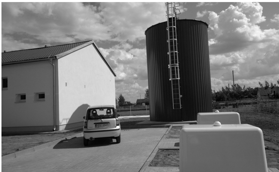
Ryc. 4. Zbiornik zapasowy i obudowy 2 studni na SUW Tolko
