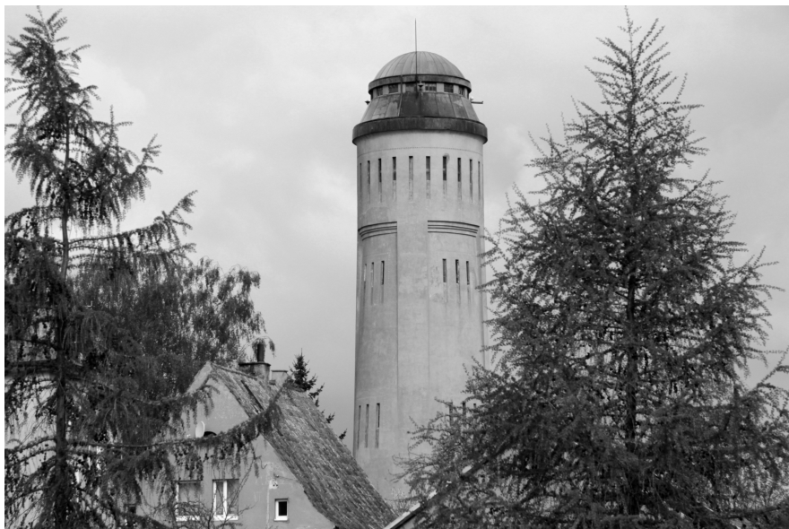
Ryc. 7. Wieża ciśnieniowa ze zbiornikiem eksploatowanym od 1905 r. (fot. B. Mulik)
