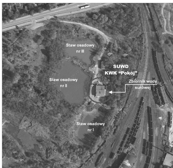
Rys. 1. Lokalizacja Stacji Uzdatniania Wody Kopalni Węgla Kamiennego „Pokój” na mapie satelitarnej – skala 1:2000.
